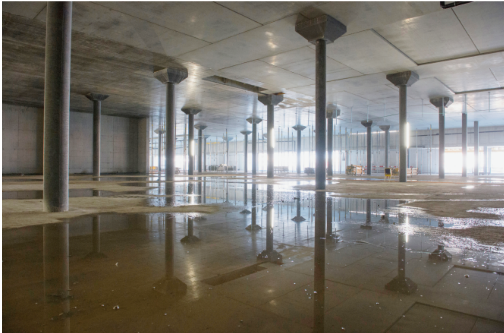
Die kommerzielle Zone im Stadionmantel kann erst im September 2015 eröffnet werden. Offenbar wegen den zu langsamen Baufortschritten.
